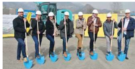
Le vendredi 18 mars dernier, des membres du conseil d'administration et de la direction de LANDI Chablais-Lavaux ont participé au lancement des travaux du futur magasin de LANDI Chablais-Lavaux à Conthey. LDD
